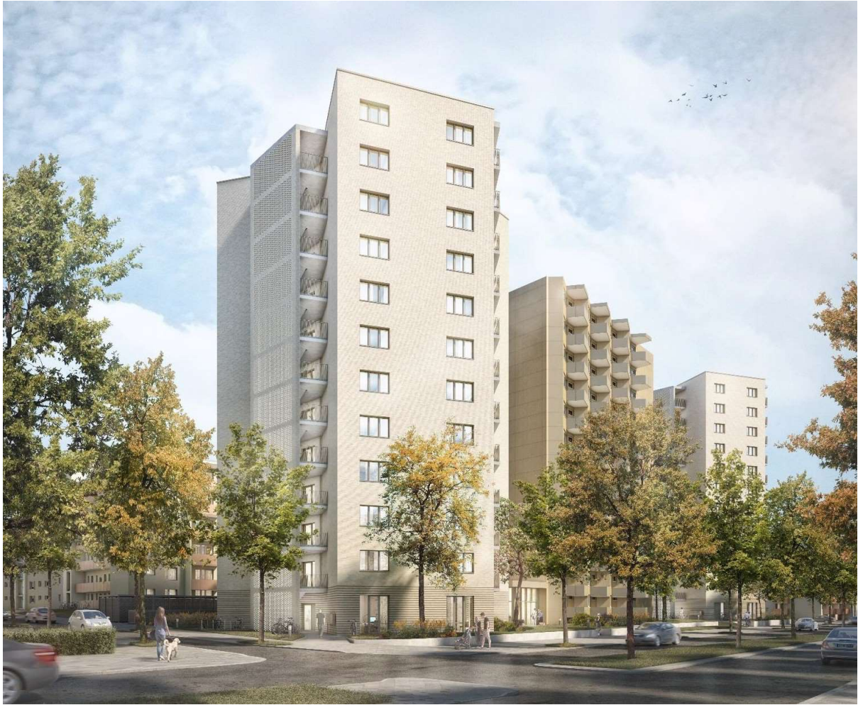
Gewobag-Projekt Mühlenberg, Häuser 2 und 1, 12geschossig, Bestandsgebäude dazwischen
